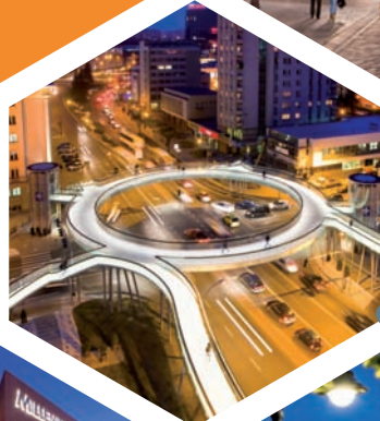
Okrúhla lávka pre chodcov
